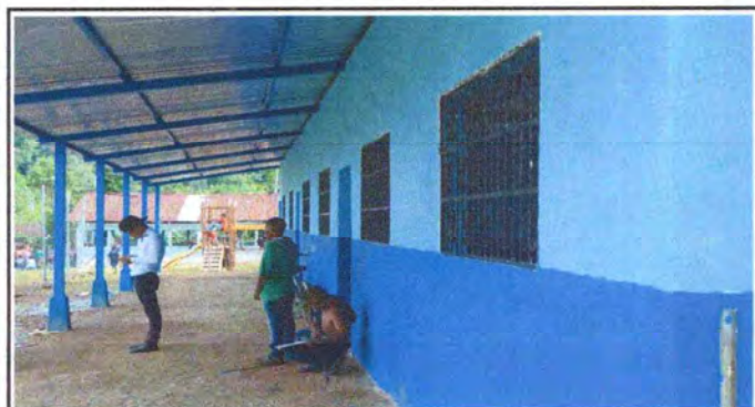
Foto 3: SUSTITUCION DE ESTRUCTURA DE TECHO.
