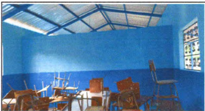
Foto 4: SUSTITUCCION DE PARED DE MADERA POR PAREDE DE BLOCK.
