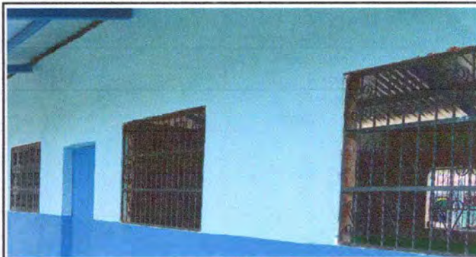
Foto 2: MEJORAMIENTO DE VENTANAS POR BALCONES DE METAL
