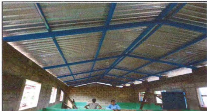
Foto1: SUSTITUCION DECUBIERTA DE LAMINAS.
